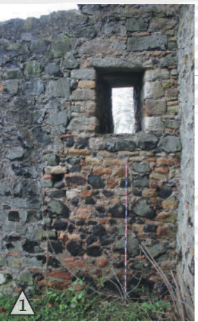
Baunaht zwischen den Bauphasen I und III im Hauptgebäude
